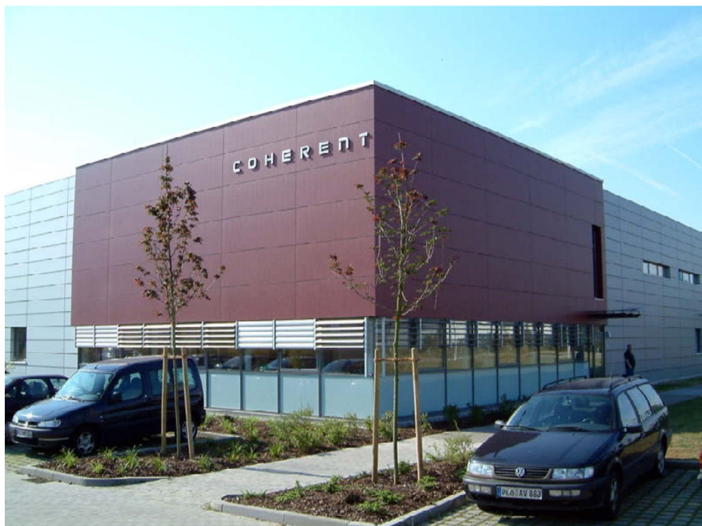
Straßenansicht des Baubestands von 2003
